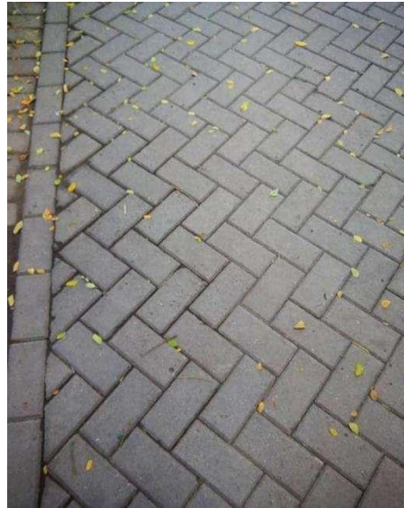
Gambar 5. 5 Ilustrasi penggunaan material Paving Block mutu K-300 untuk perataan area parkir. (Contoh referensi merek: Conbloc Indonesia atau Cisangkan).
