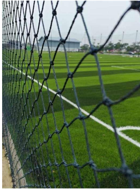
Gambar 5. 10 Ilustrasi jaring pembatas lapangan berbahan Polyethylene (PE) ketebalan 4 mm - 5 mm. (Contoh referensi merek: Marlin atau Penyu).
